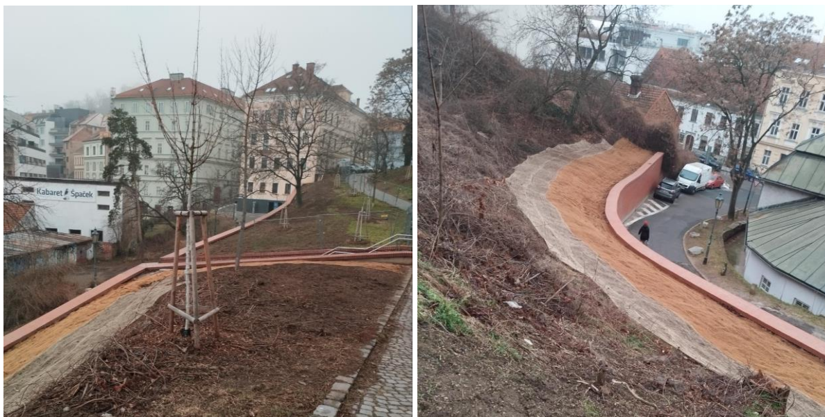
Park Studánka – vegetační úpravy po dokončené opravě opěrné zdi
