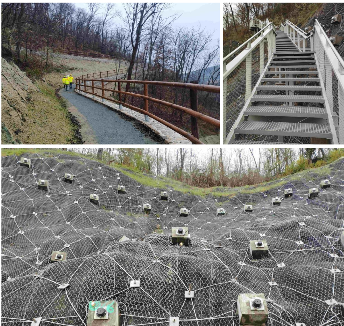
Úpravy v rámci VMO Žabovřeská, které navaazují na lesopark Wilsonův les
