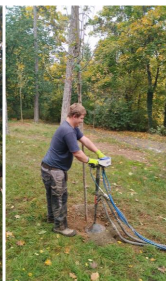
Výsadby podpořené injektáží
