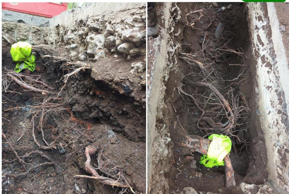
Obr. 15: Průběh kořenové sondy B – horizonty, významná navážka (stavební materiál, cihly)
