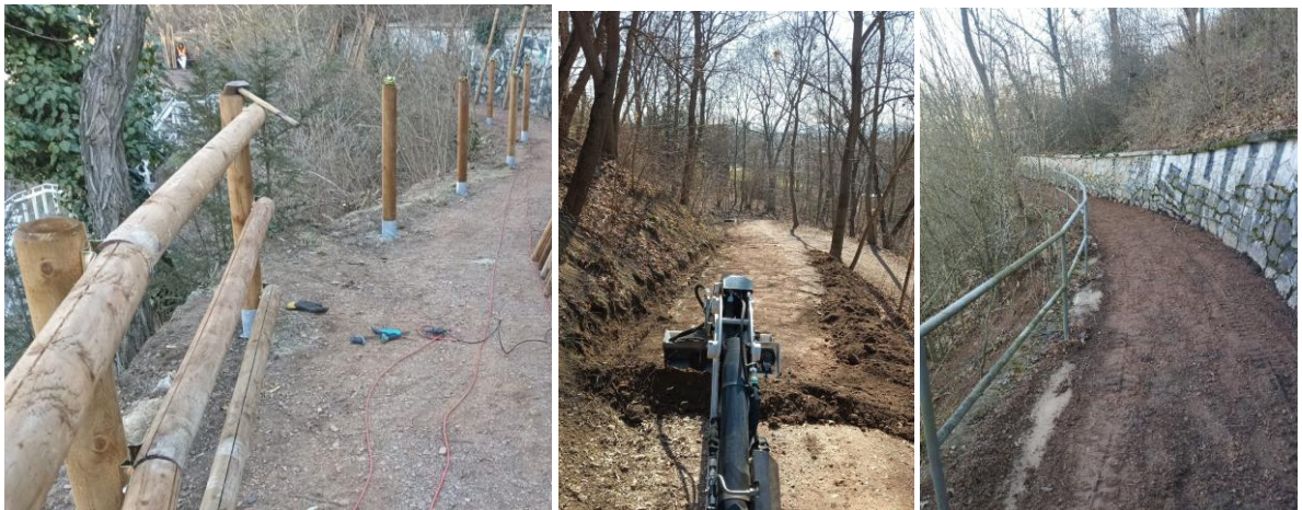
Doplnění nového zábradlí a úpravy mlatových povrchů (od Hroznové, Preslové, nové serpentiny VMO)
