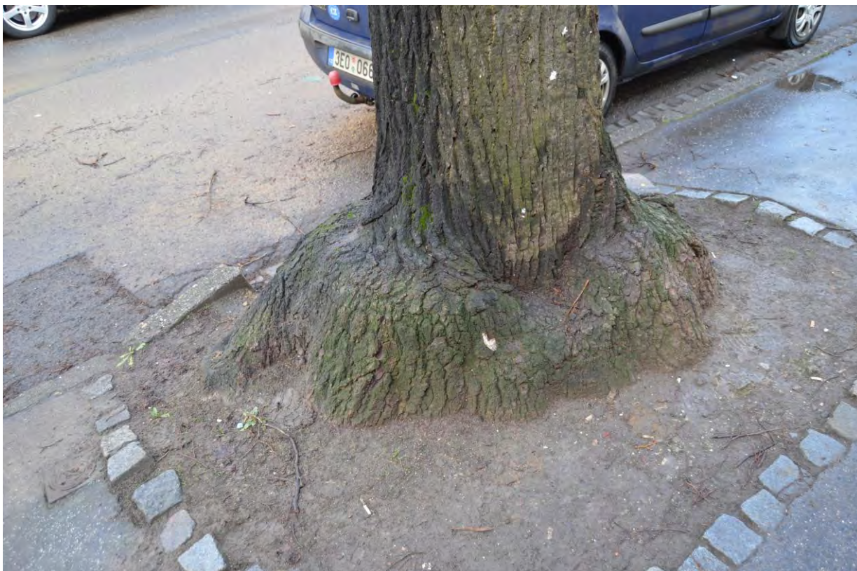
Tilia platyphyllos Scop. – lípa velkolistá č.49 pohled na bázi kmene zvedající chodník a obrubníky
