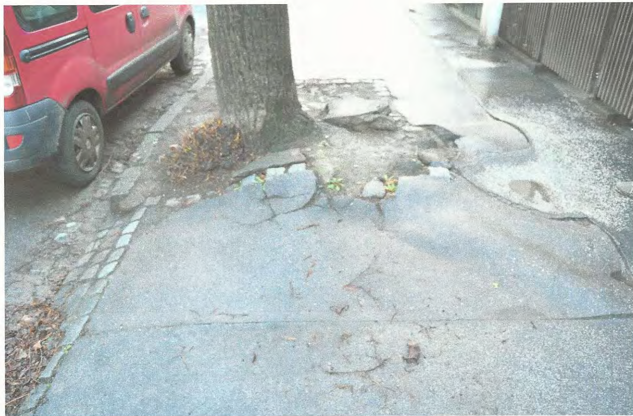
Tilia platyphyllos Scop. – lípa velkolistá č.40 pohled na bázi kmene a kořeny zvedající chodník
