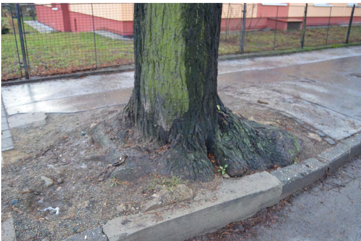
Tilia platyphyllos Scop. – lípa velkolistá č.59 na bázi kmene zvedající chodník a obrubník
