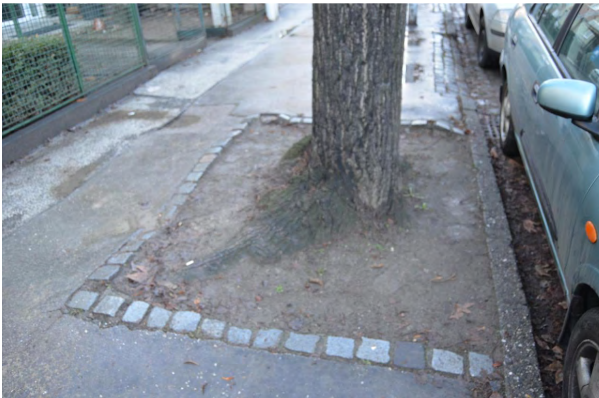
Tilia platyphyllos Scop. – lípa velkolistá č.35 pohled na bázi kmene a kořeny zvedající chodník
