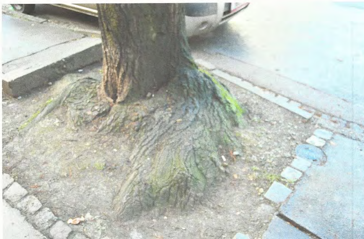
Tilia platyphyllos Scop. – lípa velkolistá č.47 pohled na bázi kmene zvedající chodník a hydrant
