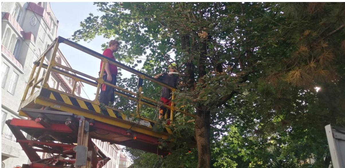
ul. Kotlářská – řez od trolejí z izolované plošiny DPmB
