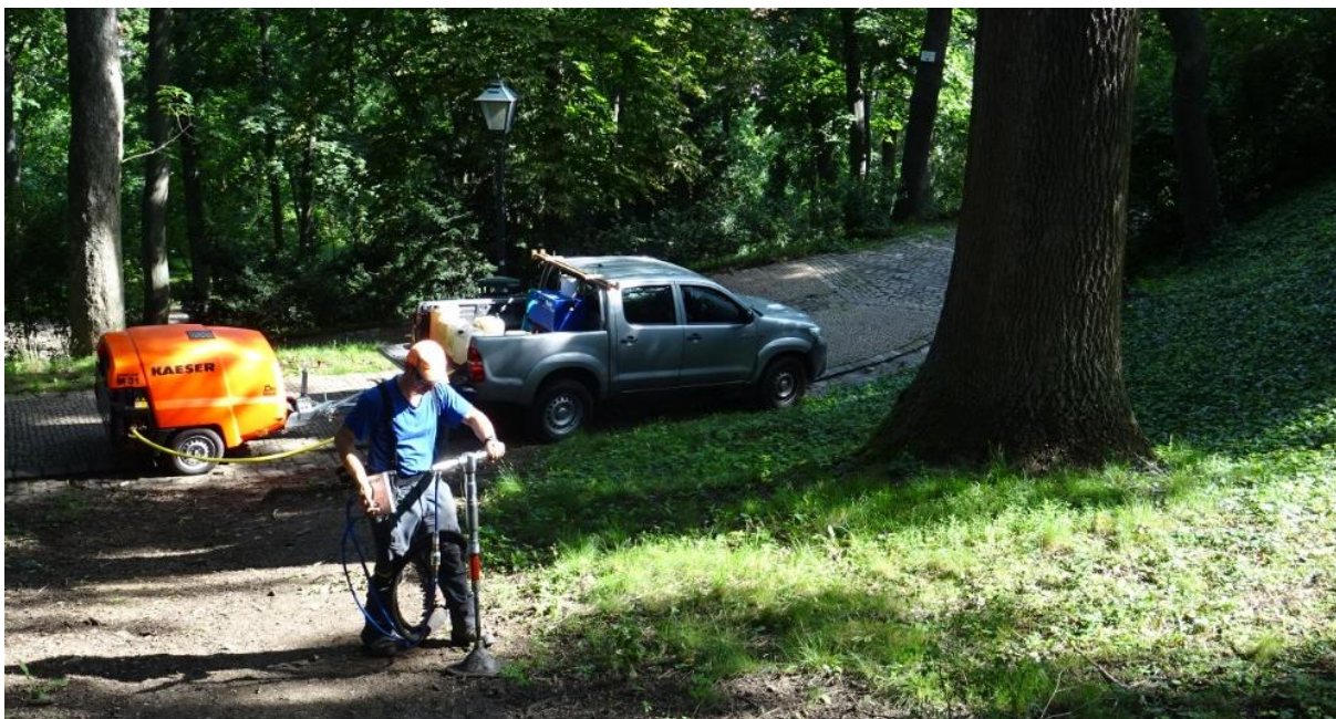
půdní injektáž s následnou aplikací hydrogelu
