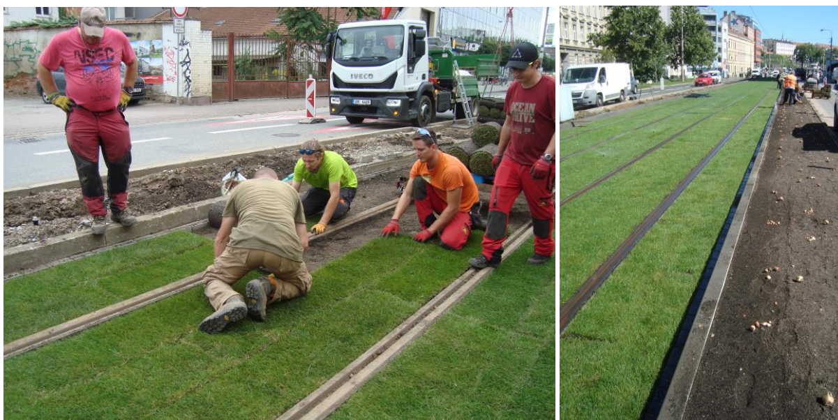
Nové sady – pokládání travního koberce a výsadba cibulovin v prostoru tramvajového tělesa
