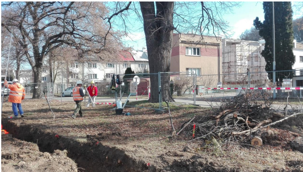
provádění dozoru ochrany památného stromořadí na ul. Bráfově na stavbě VMO Žabovřeská
