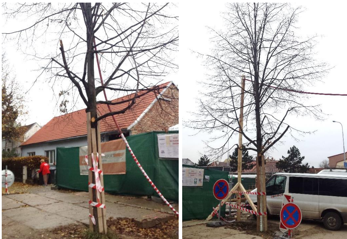
Kontrola ochrany dřevin při stavbě na ul. Vančurova - stav před a po provedení opatření
