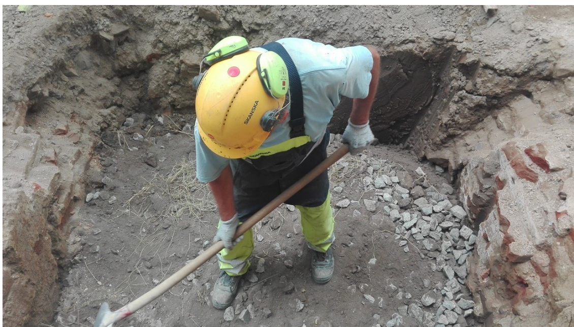
instalace prokořenitelných buněk a výsadba stromů na Dominikánském náměstí
