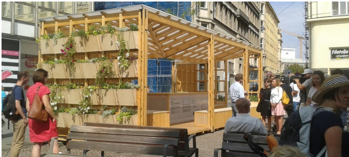
Malinovského náměstí před OD Centrum – Městská buňka, slavnostní uvedení do provozu srpen 2018 (foto VZmB)
