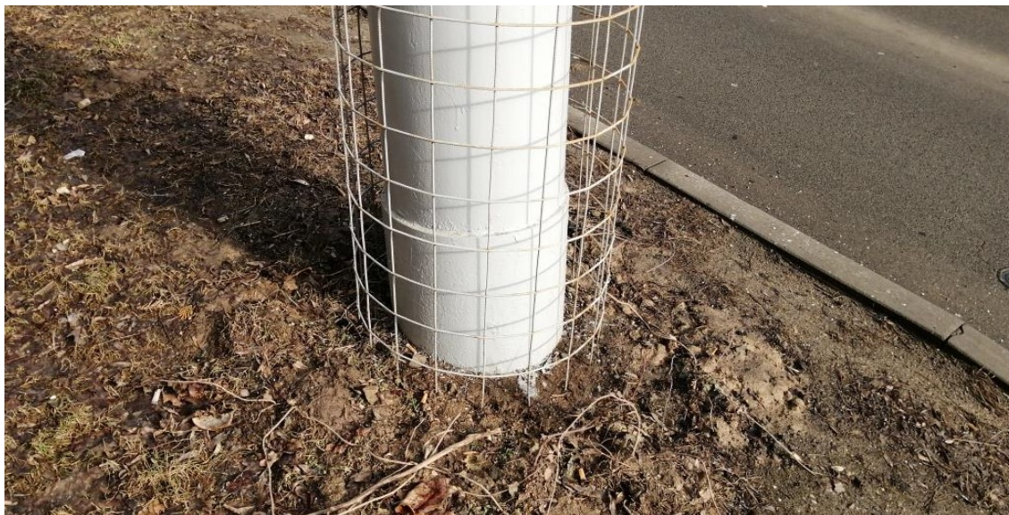
Ulice Úvoz – pomocná konstrukce z kari sítě, rostliny bude nutno mříží zpočátku proplést, zima 2019 (foto VZmB)
