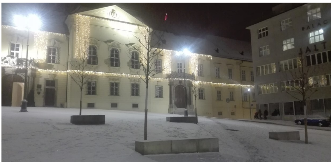
instalace prokořenitelných buněk a výsadba stromů na Dominikánském náměstí
