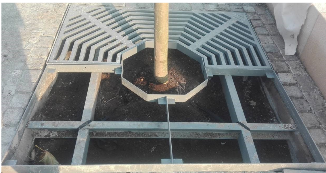
instalace prokořenitelných buněk a výsadba stromů na Dominikánském náměstí
